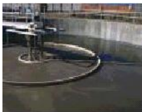
Spracovanie odpadovej vody
